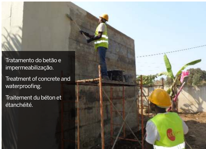
Tratamento do betão e impermeabilização dos reservatórios de água potável. Treatment of concrete and waterproofing of potable water reservoir. Traitement du béton et étanchéité du réservoir d'eau potable.
