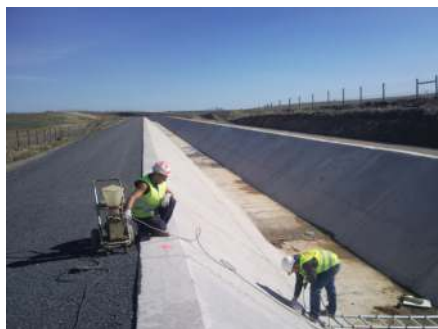
Adutor de Pedrógão, Moura.
