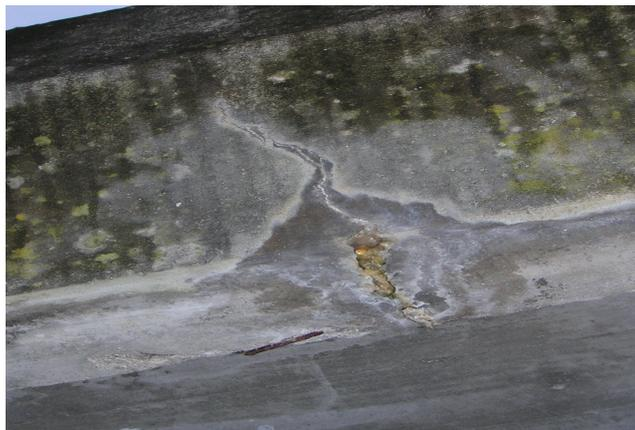
La omisión de la definición del ambiente, la incorrecta selección de los materiales y una mala ejecución han causado la carbonatación y la corrosión de la estructura, situada próxima al mar.
