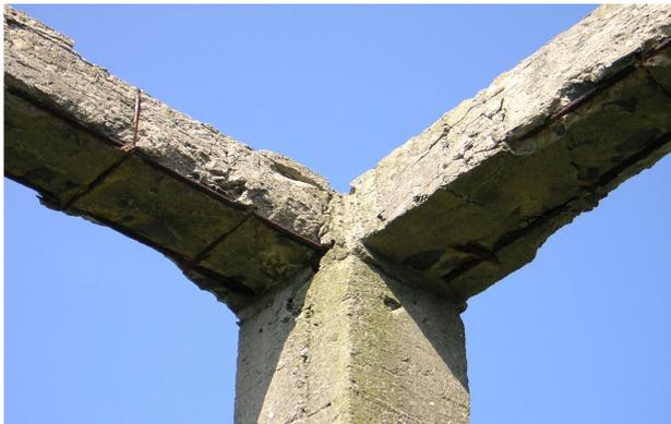
Ejemplo claro de corrosión por cloruros de las armaduras de dos vigas. Esta construcción estaba situada a la orilla del mar en una zona rural; con toda seguridad la ejecución de la estructura careció de todo tipo de control: posición de las armaduras, recubrimientos, etc.
