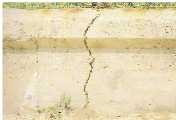
Fisuración en una valla de hormigón en masa que al carecer de armado mínimo rompe con facilidad. No tiene trascendencia estructural, pero podría haberse evitado realizando juntas a la distancia adecuada.
