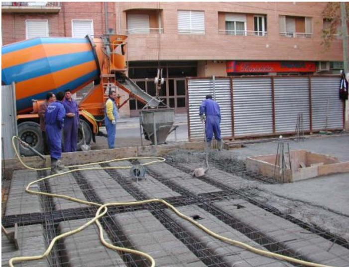
La compactación se suele realizar mediante vibrado. Este sistema disminuye el rozamiento entre las distintas partículas del hormigón y por la acción de la gravedad este tiende a asentarse rellenando todos los huecos del molde, adaptándose a las superficies del mismo y al contorno de las barras de armado.
