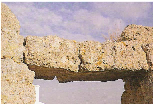
En la imagen se observa como rompe a flexión un dintel de piedra. La rotura avanzó desde la zona de tracción en el inferior hacia la zona de compresión, cesando al alcanzar la fibra neutra.
