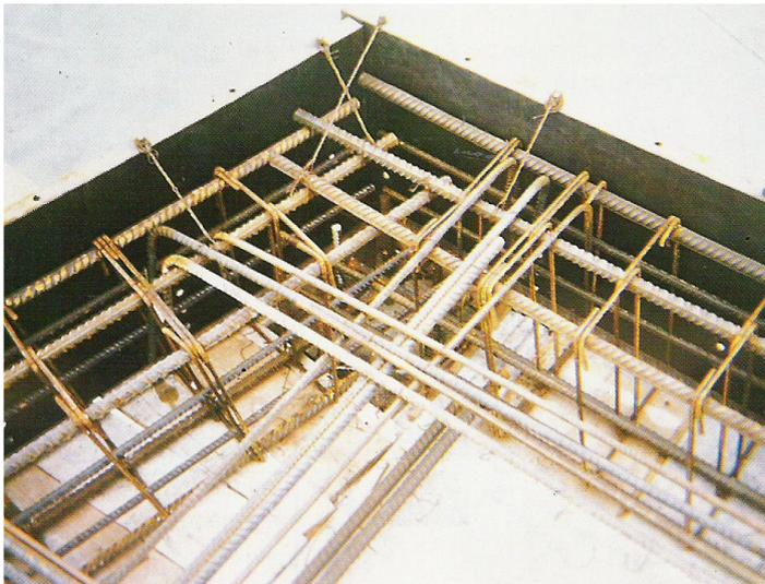
La armadura de negativos se dispondrá hasta la cara del apoyo, a partir de aquí se anclará en una longitud igual a la longitud neta. La ausencia del anclaje permite el deslizamiento de la armadura en el hormigón que se fisurará a tracción por no trabajar correctamente, como muestra la imagen.
