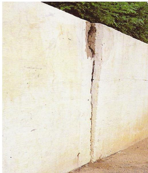
Inicio de vuelco en dos muros de contención, causado por el empuje activo de las tierras y tener una cimentación insuficiente para soportar dicho empuje.
