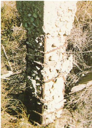
Ejemplo de la desagregación que ha sufrido un pilar de hormigón armado. La causa en este caso al no encontrarse en un ambiente muy agresivo puede deberse a la utilización de áridos contaminados. Estos al reaccionar con el agua acumulada en los poros del hormigón han provocado esta situación. Si no se adoptan medidas, el hormigón tendrá cada menor resistencia pudiendo llegar al colapso.
