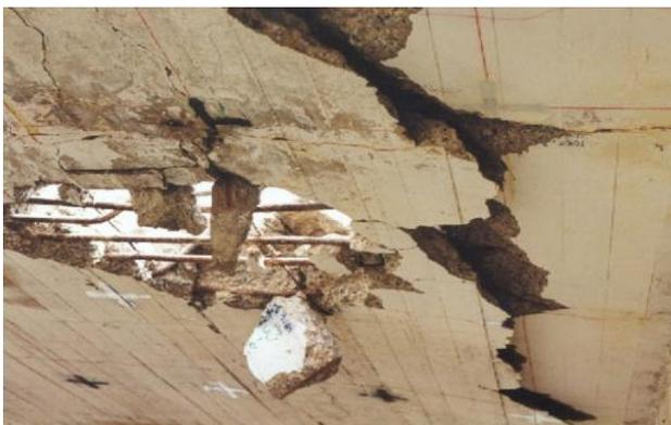
En la foto se observa la rotura de un tablero de un puente por punzonamiento. El puente fue diseñado con hormigón de alta resistencia, pero esto no sirvió de nada ya que el espesor del tablero no fue el adecuado para los esfuerzos tan concentrados que soportaba.
