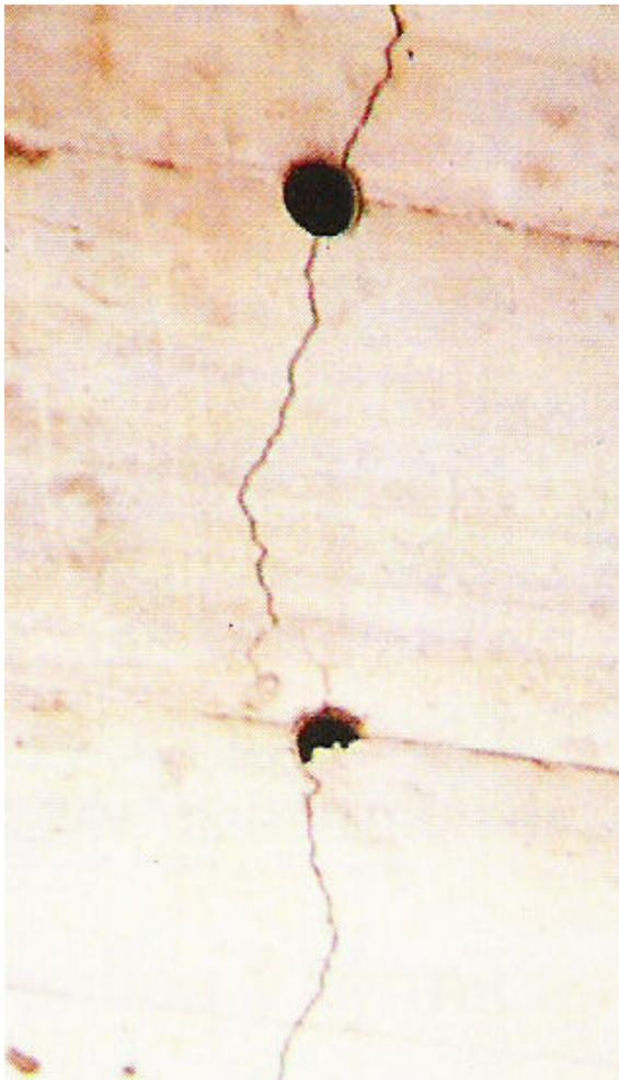
Ejemplo de fisura por contracción térmica en un muro de contención. Son más abiertas en la coronación del muro y se van cerrando a medida que descienden quedando con frecuencia su línea de rotura en discontinuidad. En ocasiones se pueden confundir con las fisuras que produce un asiento.
