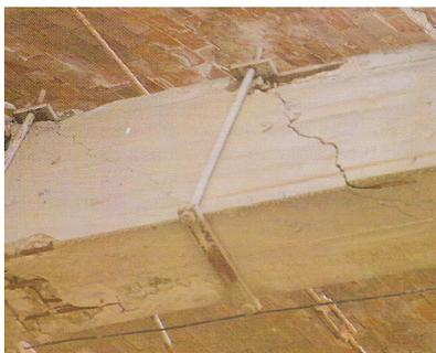
Fisuración de una viga que no ha sido capaz de soportar la torsión. Se observa que en este caso dio tiempo ha tomar medidas y se reforzó la viga (ver Apartado 2.3 del capítulo II) antes de que se produjese el colapso.
