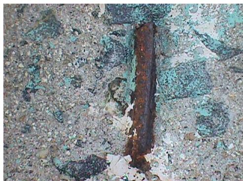
Las reacciones expansivas de la etringita han provocado la destrucción del recubrimiento de hormigón, dejando expuesta la armadura. El riesgo ahora aumenta debido a la posible corrosión que puedan sufrir las barras de acero. Se hace necesario tomar medidas para evitar que el proceso empeore más la situación.
