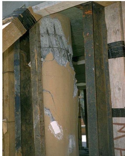
En la imagen se observa el colapso por sismo de un pilar circular de la planta baja.
