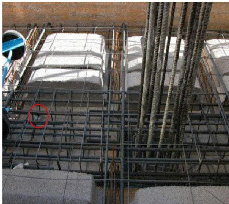
Una practica habitual en la obra es la de emplear cualquier cascajo o trozo de mortero como separador. Esto acarrea el problema de que la armadura pueda desplazarse al verter el hormigón y no permita que el recubrimiento del hormigón se reparta uniformemente. En el mercado existen multitud de modelos de diversos materiales que se acoplan fácilmente a las barras y que garantizan los recubrimientos.
