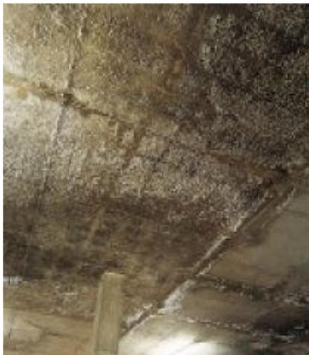
La imagen muestra el forjado de un parking que ha sufrido la acción continua de los ciclos de hielo-deshielo provocando la disgregación de la pasta de cemento. En este momento sería interesante plantearse la aplicación de algún sistema de protección (ver Cáp. II) para evitar que la situación fuera a mayores.
