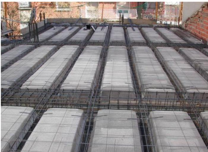
El espesor de recubrimiento alrededor de los empalmes debe ser suficiente porque de lo contrario se pueden producir patologías al no poder transmitir el esfuerzo de una barra a la otra por falta de hormigón. Es preciso asegurarse que el hormigonado se realiza adecuadamente en las zonas en que se han colocado empalmes.
