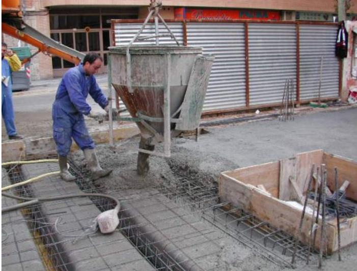
El sistema más empleado en la puesta en obra del hormigón es el vertido desde el dispositivo de transporte a una cuba, y de este a los encofrados o moldes. Existen otros métodos como el bombeo o la proyección de hormigones o morteros que se emplean mucho en reparaciones.
