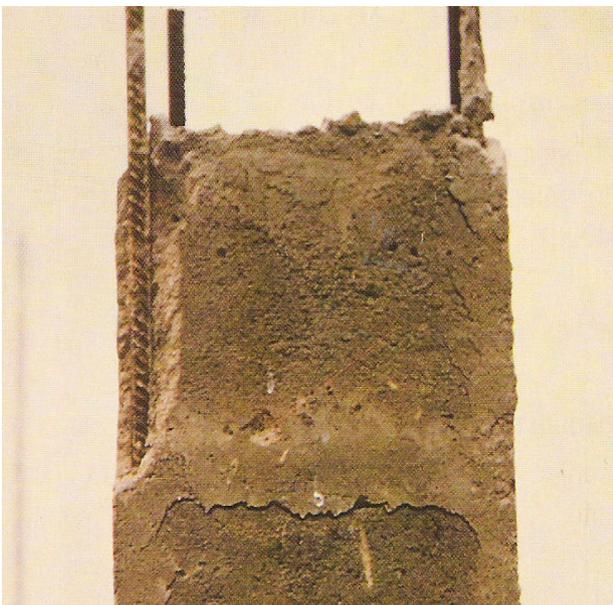
Clásicas fisuras de asiento plástico en la cabeza del pilar, ocupando la posición de los estribos. Esta se produce porque el hormigón debajo del estribo asienta, mientras que el que se encuentra por encima no puede bajar por estar coartado y se fisura.
