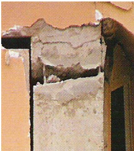
Rotura de la parte superior de un pilar poco armado. En este caso la rotura aparece como una grieta abierta que lo secciona, al pasar de la compresión típica de los pilares a la tracción no prevista en el cálculo.
