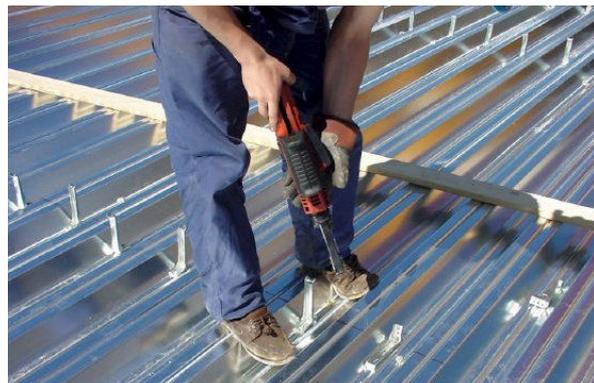
Este tipo de rotura es muy común en los forjados mixtos, que están compuestos por un perfil de acero y una capa de hormigón. Para garantizar la adherencia entre ambos materiales y evitar el peligro del esfuerzo rasante se colocarán a lo largo de toda la placa conectores metálicos.
