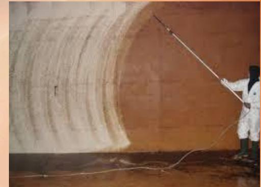
Permite remoção dos sedimentos acumulados no fundo e das partículas de óxidos que se encontram em fase de consolidação.
