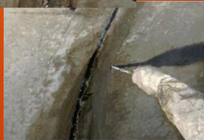
Selagem de fissuras com intensa fuga de água em barragens.
