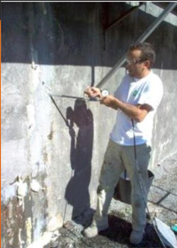
Reparação estrutural de reservatórios de água
