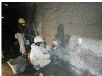
Túnel da barragem de Capanda - Malange
