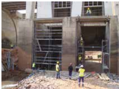
Tratamento do betão e impermeabilização; Barragem do Calueque-Cunene.
