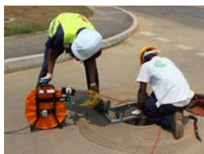
Mostra de inspeção por vídeo em condutas.
