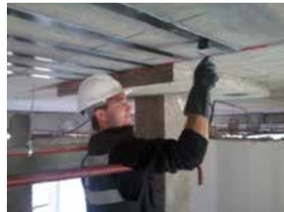
Reforço estrutural de lajes de betão armado.
