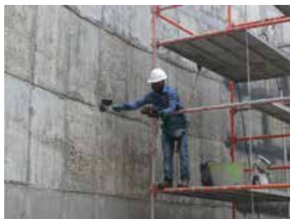
Tratamento do betão e impermeabilização dos reservatórios de água potável; CD Camama - Luanda
