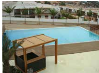
Assistência técnica para a manutenção e controlo do sistema de tratamento da água da piscina. Belas - Luanda
