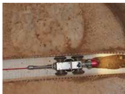
Mostra de inspeção por vídeo em condutas.
