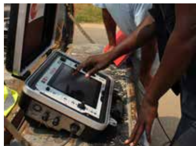
Monitorização da inspeção por vídeo em condutas.
