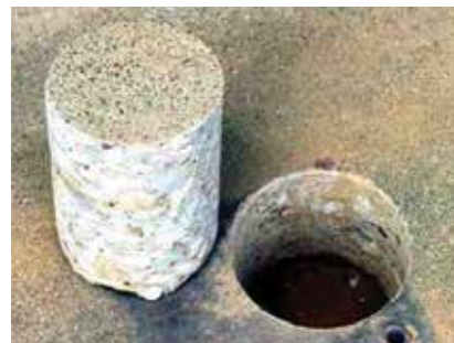
Execução de furação em lajes de betão armado.
