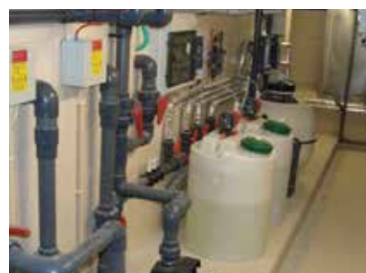
Manutenções de sistemas de tratamento de água.
